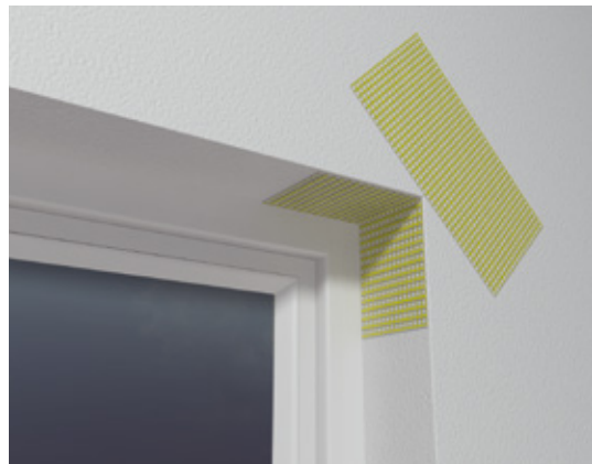
Eckausbildung mit Diagonalarmierung
