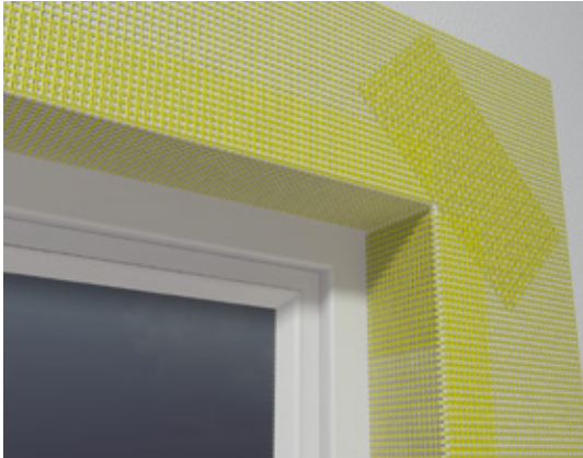
Armieren der Laibungen mit RELIUS GEWEBEWINKEL PVC GELB, Diagonalarmierung mit Armierung vom Fenstersturz
