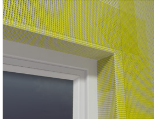
Armieren der Laibungen mit RELIUS GEWEBEWINKEL PVC GELB, Armierung seitliche Laibungen
